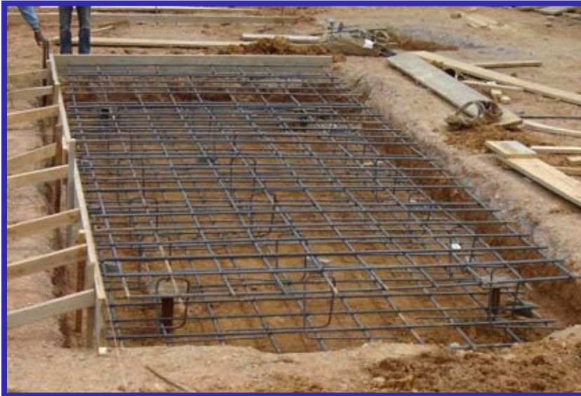
New Construction Helical Piles before Slab Pour
